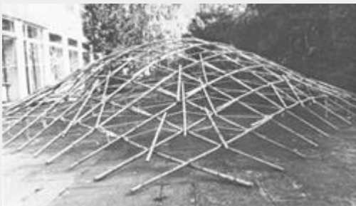
Aufbau einer Gitternetzku­p­pel
